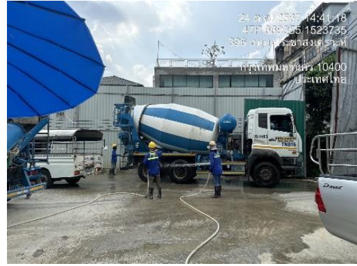
รูปที่ 13 เจ้าหน้าที่ฉีดล้างล้อรถ
