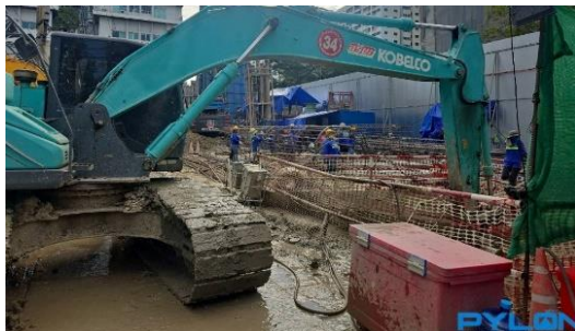
รูปที่ 27 ขุดลอกตะกอนบ่อดักตะกอน
