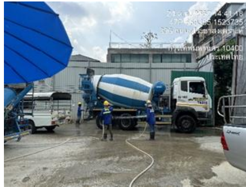
รูปที่ 13 เจ้าหน้าที่ฉีดล้างล้อรถ (ต่อ)
